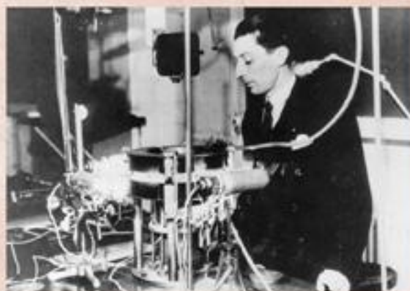
Marie Curie s'apprête à filmer les traces de trajectoires de particules obtenues grâce à la chambre de Wilson
